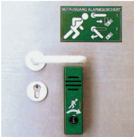
Bild 6: Türwächter Der Türwächter verhindert in Grundstellung das Betätigen des Türdrückers.
